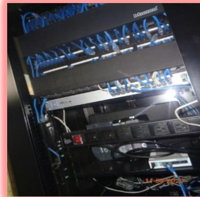
Instalación de gabinete de rack
